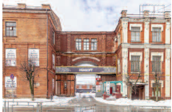
Những lãnh thổ công nghiệp bị bỏ hoang trong thành phố Ivanovo.
