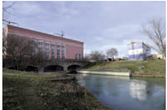
Tòa nhà nhà máy thủy điện Sengilevsk.
