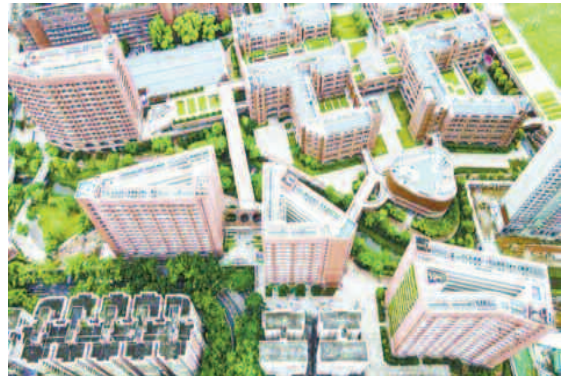
Kí túc xá Trường THPT Thâm Quyến - địa điểm triển khai dự án bổ sung thang máy mới.
