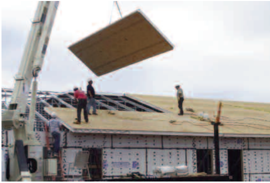
Việc xây dựng bằng các tấm SIP là bền vững, giúp rút ngắn thời gian xây dựng và cải thiện đáng kể hiệu quả sử dụng năng lượng tổng thể của cấu trúc.
