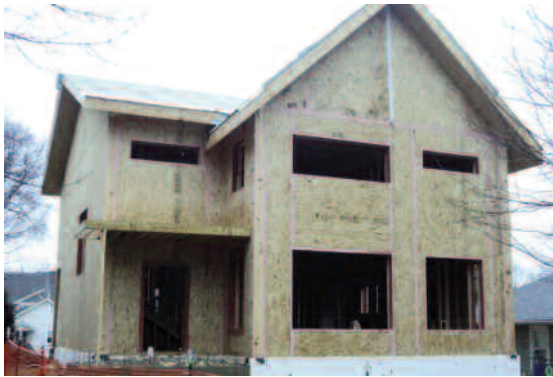
Tấm cách nhiệt kết cấu là một loại tấm composite tiết kiệm năng lượng, thường được sử dụng để xây tường, sàn, mái và móng cho các dự án xây dựng dân dụng.
