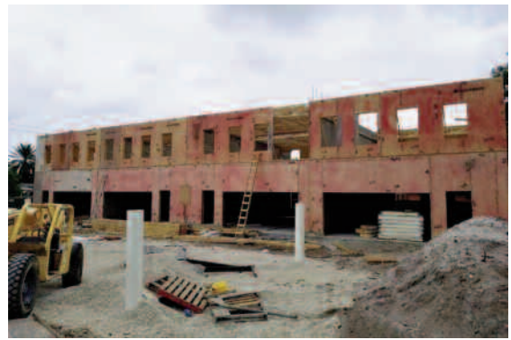
Các tấm SIPs hiện đại đã được sử dụng từ đầu những năm 1950.
