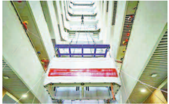
Thang máy đôi 2 cabin mới đang trong quá trình hoàn thiện.
