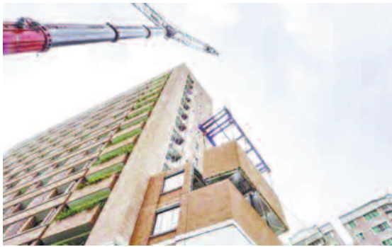
Thi công dựa trên việc áp dụng công nghệ MiC và mô hình lắp ráp tiên chế.
