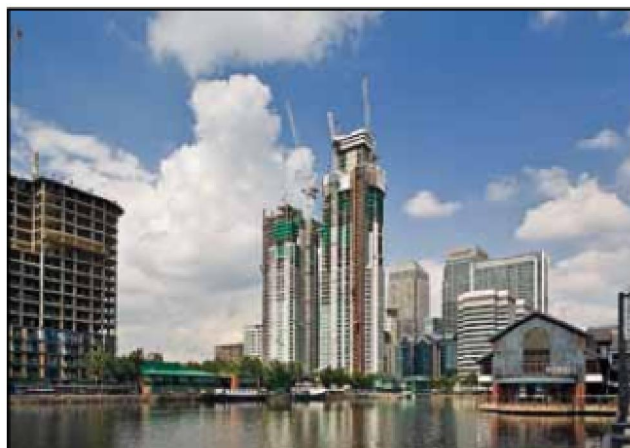
Hình 6.1 – Thi công nhà cao tầng
