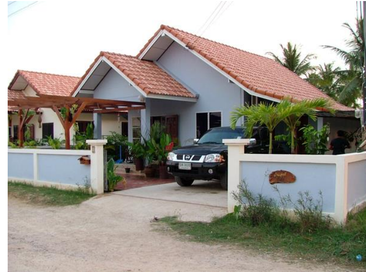
NHÀ Ở MỘT TẦNG CÓ CỘT BÊ TÔNG CỐT THÉP, TƯỜNG GẠCH VÀ MÁI DÙNG HỆ KHUNG THÉP KẾT HỢP LỢP NGÓI
