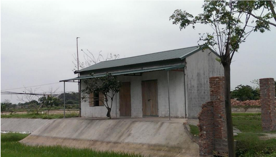
NHÀ Ở MỘT TẦNG CÓ CỘT BÊ TÔNG CỐT THÉP, TƯỜNG GẠCH VÀ MÁI LỢP TÔN
