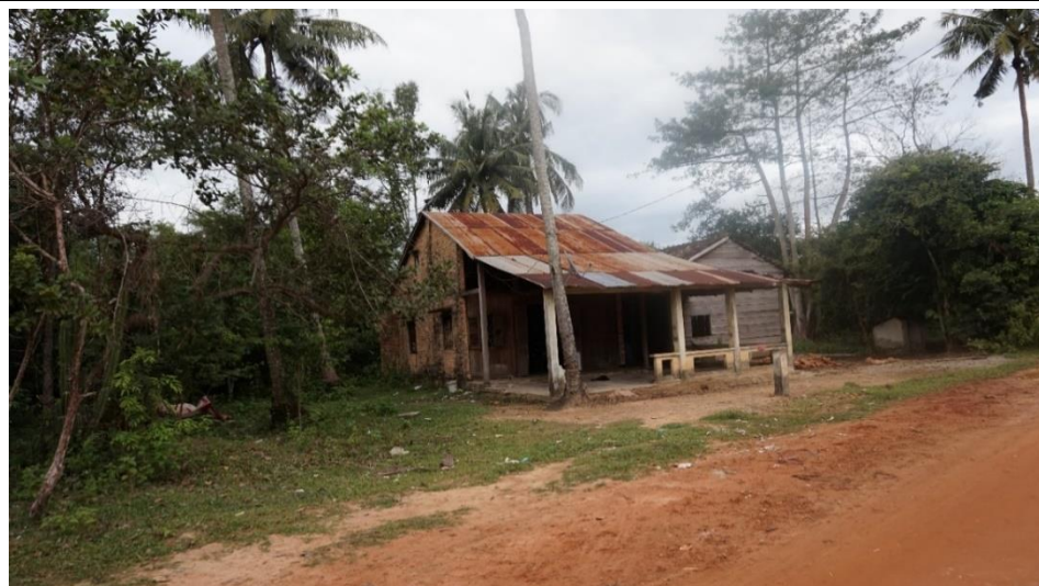
NHÀ Ở MỘT TẦNG CHỈ CÓ TƯỜNG XÂY GẠCH BỀN CHẮC, KHÔNG CÓ CỘT, MÁI LỢP TÔN
