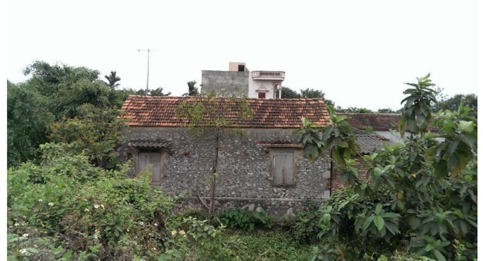
NHÀ Ở MỘT TẦNG, TƯỜNG XÂY ĐÁ KHÔNG CÓ CỘT, MÁI NGÓI
