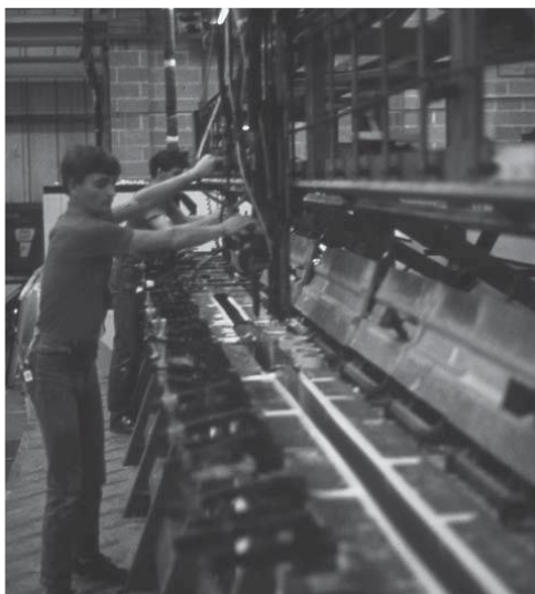
Hình 1.8 – Sản xuất panen lõi xốp – bơm xốp thẳng đứng [9]
