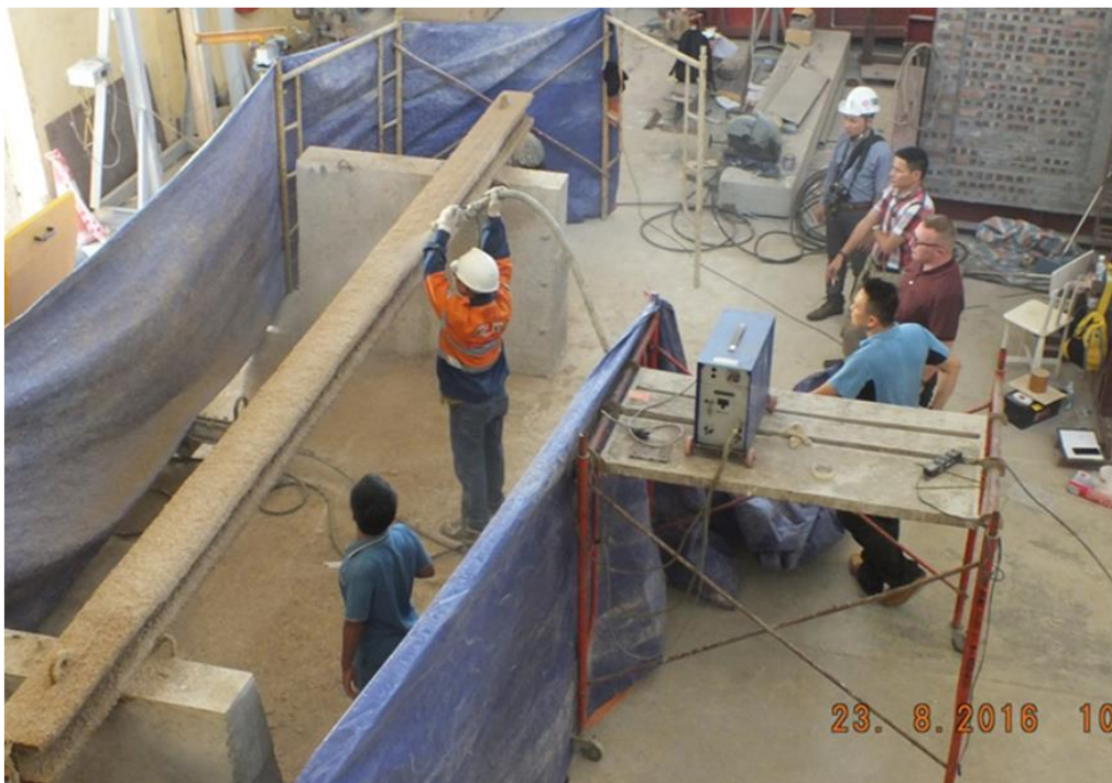
Hình 37 – Ví dụ thi công phun vữa bọc bảo vệ chịu lửa cho đầm thép
