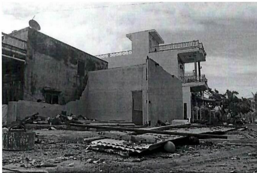
Hình 4. Hệ mái và tường bao che của một nhà dân bị phá hoại sau cơn bão số 12 (năm 2017) tại tỉnh Khánh Hòa
