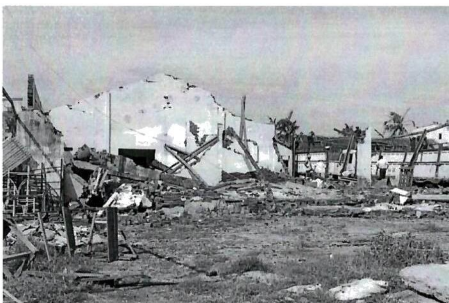
Hình 9. Một nhà ở bị phá hoại hoàn toàn sau cơn bão số 6 (năm 2006) tại Đà Nẵng
