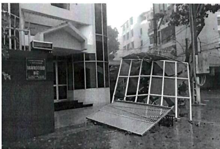
b) Hệ vách kính bị phá hoại sau cơn bão số 12 (năm 2017) tại Khánh Hòa
