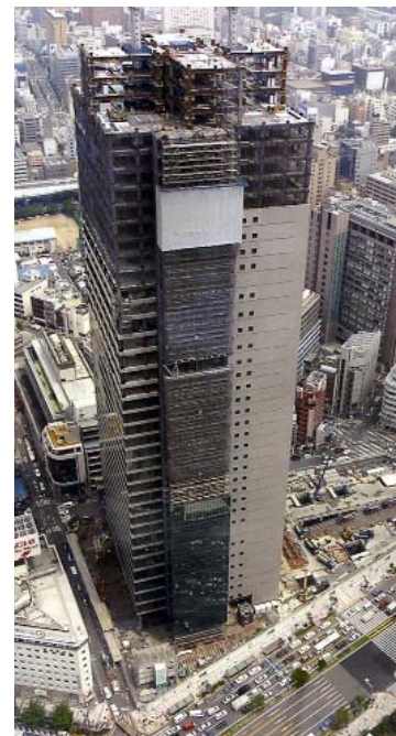
Công trình đang thi công
