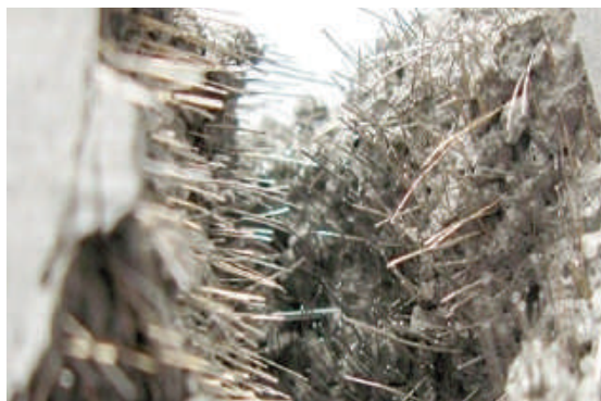
Bê tông cốt sợi.
