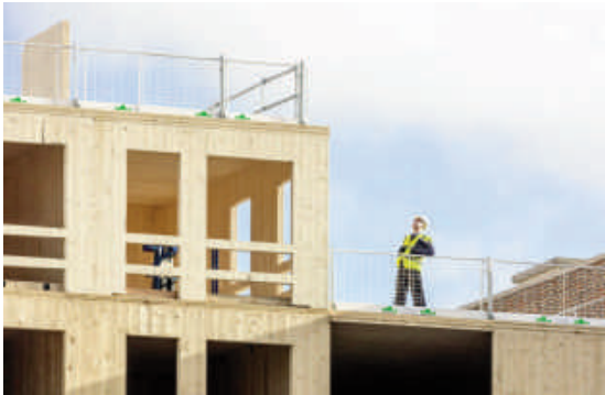
Vật liệu xây dựng bền vững như gỗ đan lớp giúp kiến trúc sư tạo ra những tòa nhà xanh hơn.
