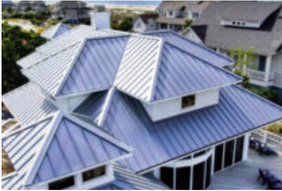
Tấm lợp bằng kim loại cực kỳ bền, có thể tái chế và phản chiếu thay vì hấp thụ ánh sáng mặt trời.
