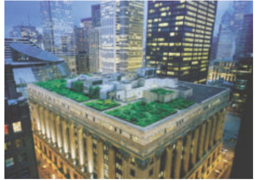
Những mái nhà green-blue tại Tòa thị chính Chicago giúp giữ cho các tòa nhà mát mẻ, giảm nước mưa chảy tràn và cung cấp môi trường sống cho các loài chim và côn trùng quan trọng.
