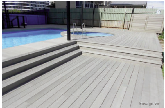
Nhựa giả gỗ ốp sàn bể bơi
