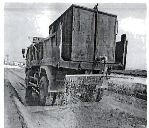
Hình 3. Công nhân rải XM trên lớp PG
