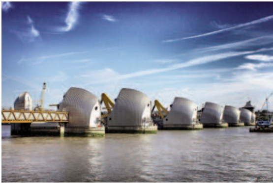
Hệ thống đập chắn trên sông Thames (Thames barrier) bảo vệ London khỏi ngập lụt
