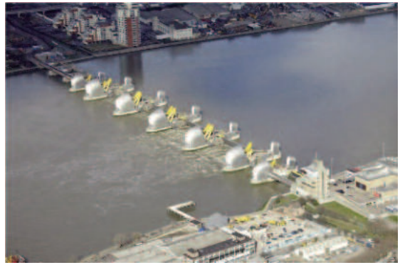
Thames barrier nhìn từ trên cao
