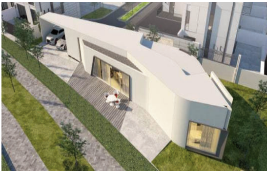
Ngôi nhà in 3D đầu tiên của dự án tại khu phức hợp Arabian Ranches III ở Dubai
