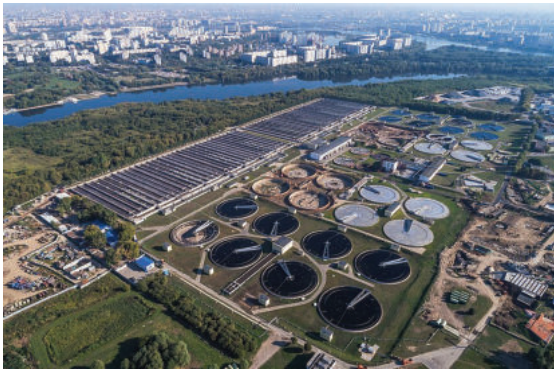
Tổ hợp xử lý nước thải bên bờ sông Moskva (Nga)
