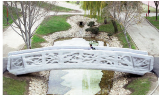
Cây cầu đầu tiên được xây bằng phương pháp in 3D
