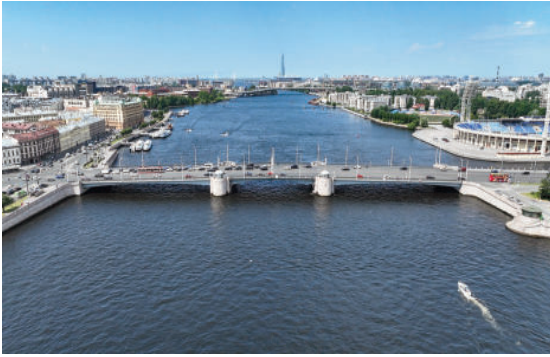
Một số công trình ứng dụng Penetron trong xây dựng/tái thiết: cầu Tushkov (St.Peterburg, Nga)
